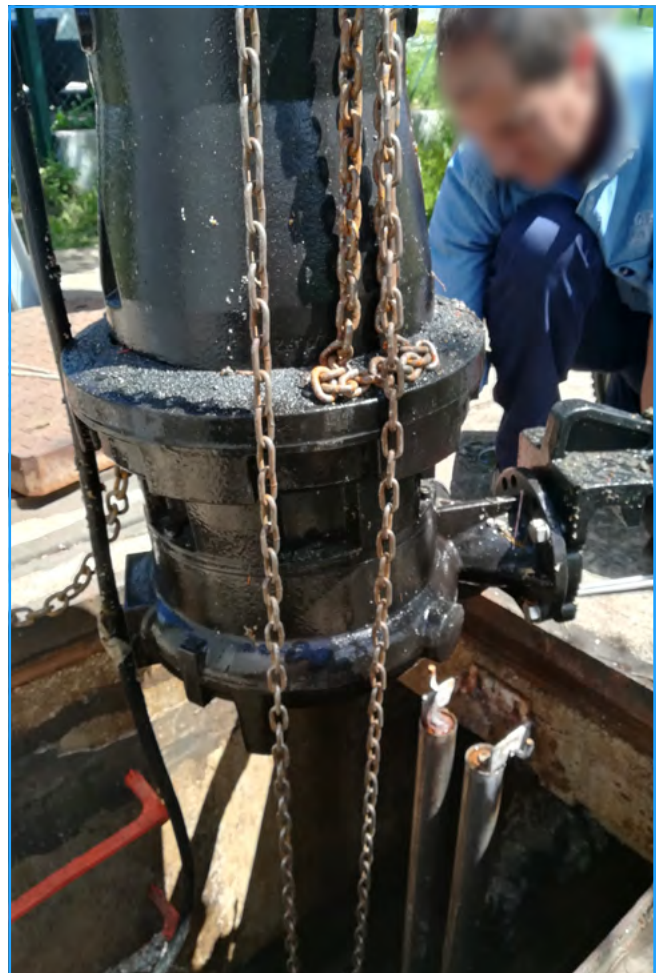
Installation von Uniqa im Brunnen
