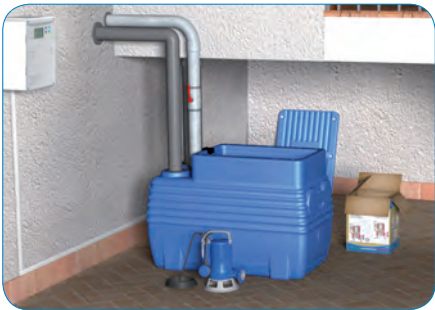
④ 安装管路
